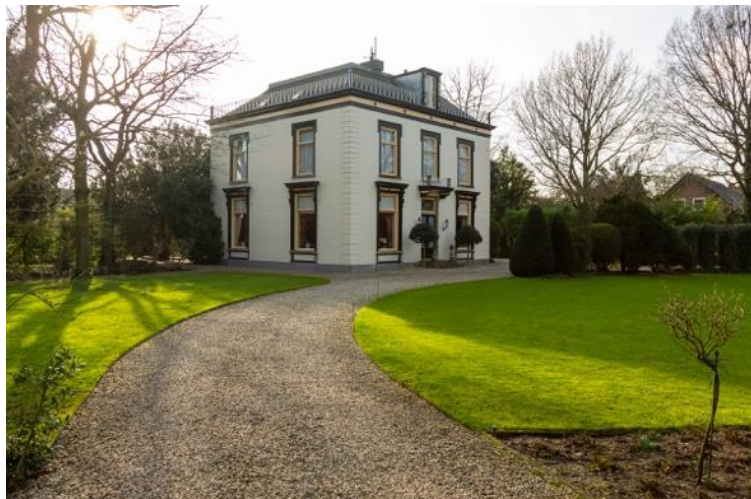
Malapertweg 17, De "Stormerdijk" uit 1850
