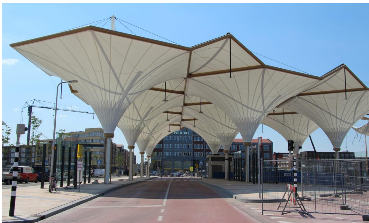
Gotische kapconstructie Busstation Leidsche Rijn
